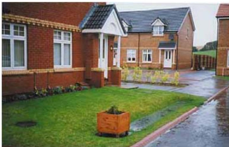
Obr. 22. příklad močálu využívaného v e stavební firmě v Dundee. Zdroj: „SmartDesign-Creating Sustainable Buildings!
