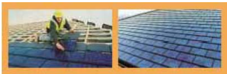
Obr. 10 Instalace PV tašek na střeše. Zdroj: „SmartDesign-Creating Sustainable Buildings“
