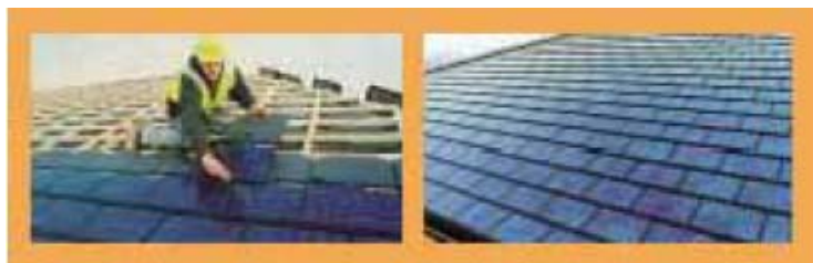
Fig. 2. Stallazzjoni ta' madum PV fuq saqaf. Sors: "SmartDesign-Creating Sustainable Buildings"
