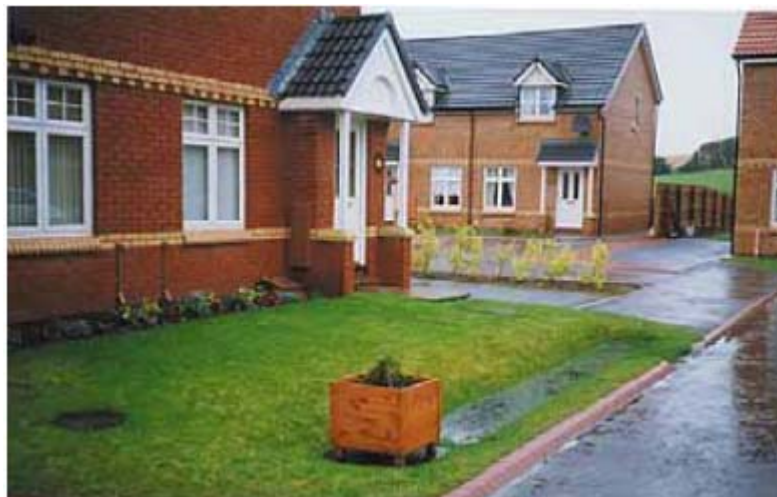
Fig. 4. Eżempju ta' swale qed jintuża f'qasam ta' djar f'Dundee. Sors: "SmartDesign-Creating Sustainable Buildings"
