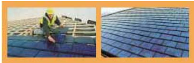
Σχήμα 10 Εγκατάσταση ΦΒ πλακιδίων σε μια στέγη Πηγή: “SmartDesign-Creating Sustainable Buildings”
