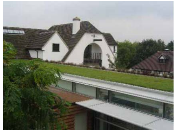
Σχήμα 23 Λεπτομέρεια και φωτογραφία κατασκευής πράσινης οροφής.
